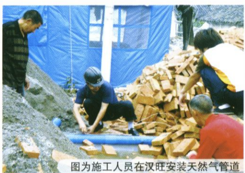
图为施工人员在汉旺安装天然气管道
